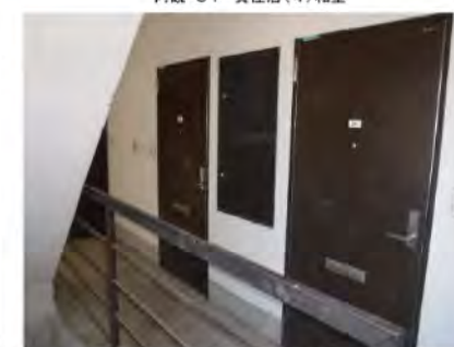
内観-2F-共同住宅階段ホール
