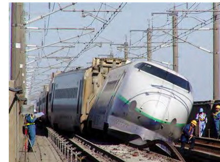
脱線する上越新幹線 (中越地震)
