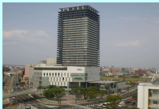
<熊本駅前東A地区(熊本市)> 駅周辺地区の再整備
