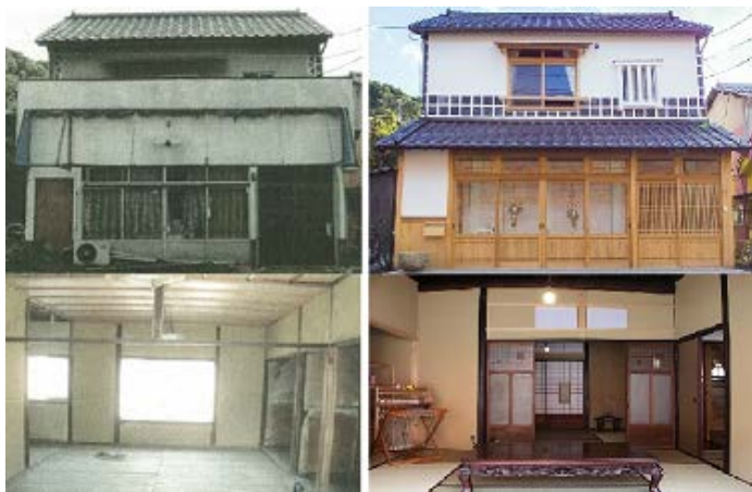
(ゲストハウス「パルビゾン」改修前・改修後)
