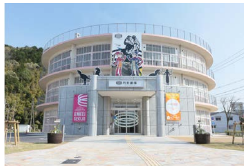
商業施設として新たに整備
