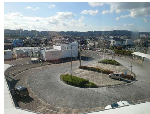
〈島田駅南口ロータリーの様子〉
