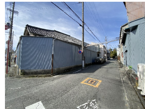
〈事業実施予定箇所〉
