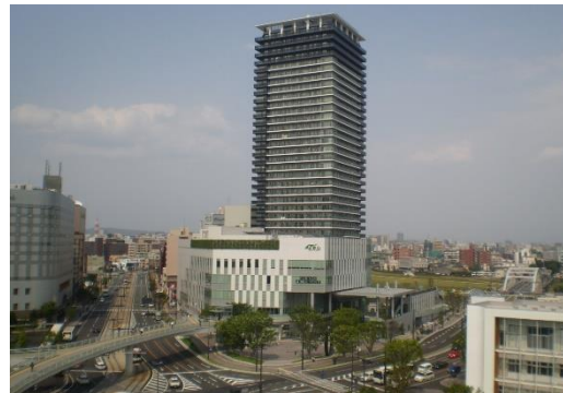
整備後(平成24年)
