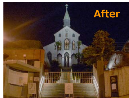
令和元年9月完成
