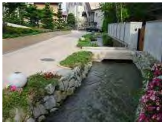
南八幡川親水性水路建設事業
