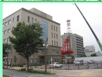
シビックコア 裁判棟(左)と行政棟(建設中)
