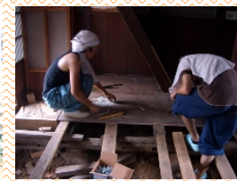
内部のリフォーム状況
