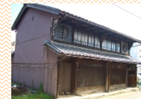
改修する町屋
