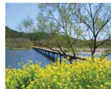
沈下橋（佐田沈下橋）
