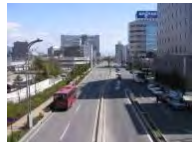
整備された都計道七瀬・中御所線
