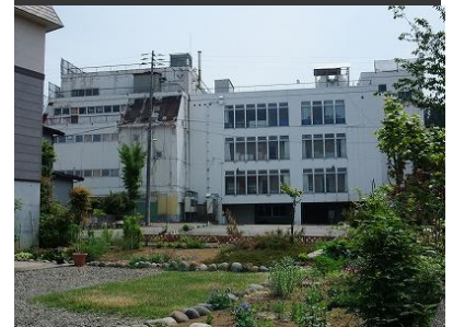
旧田倉：平成16年の中越大震災の被災により廃業した大型商業ビル（平成24年11月解体）
