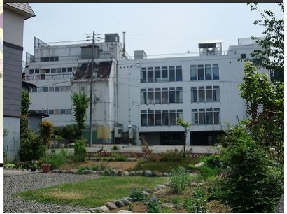
旧田倉：平成16年の中越大震災後に廃業した大型商業ビル（平成24年11月に解体）
