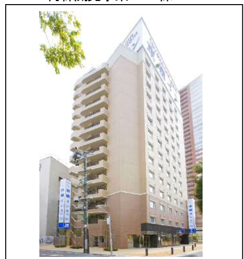
《 旭・板屋地区第一種市街地 》 再開発事業 B-2 棟
