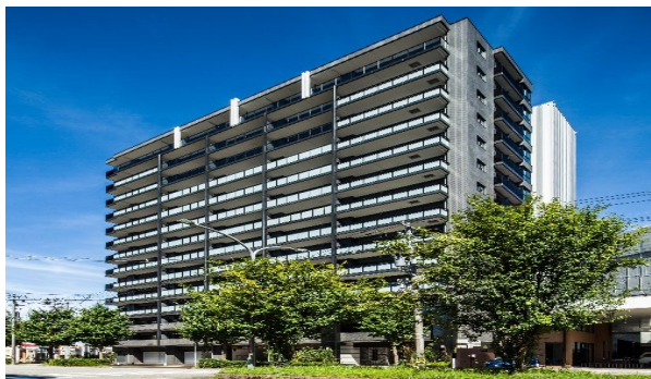
事業を活用して整備された共同住宅
