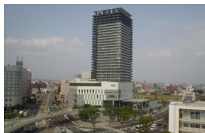
再開発で整備した「くまもと森都心」
