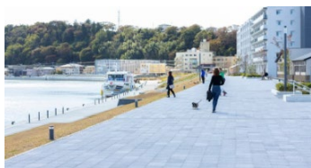
北上川河川堤防
