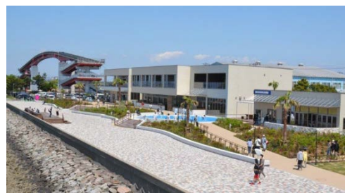
整備完了後の様子
