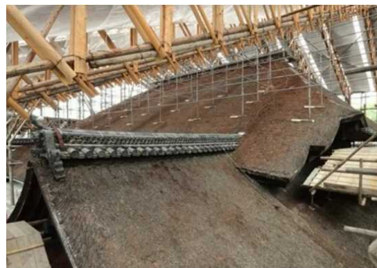
国宝清水寺本堂屋根仮設の様子(京都府)
