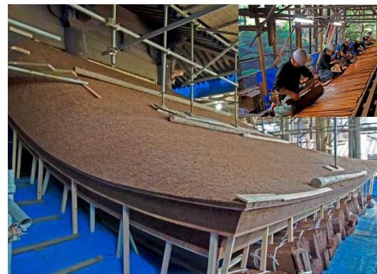
国宝清水寺本堂屋根檜皮葺施工状況(京都府)
