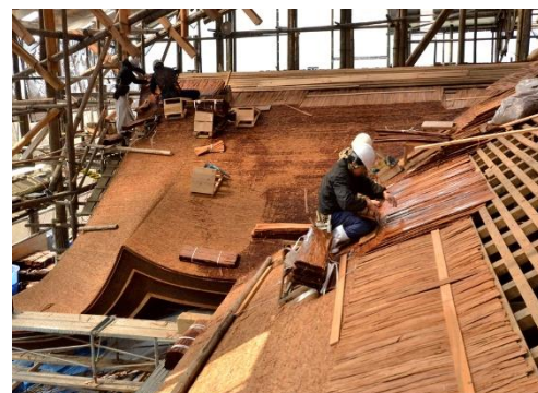
国宝清水寺本堂屋根施工の様子（京都府）
