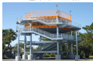
避難タワーの整備
