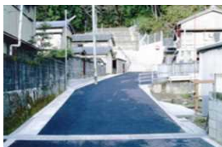
避難路の整備
