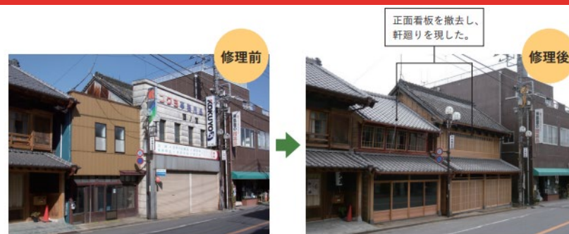
香取市佐原伝統的建造物群保存地区の修理事例
