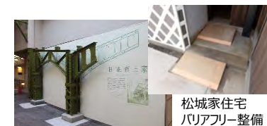
松城家住宅 バリアフリー整備 スロープの設置 （静岡県）
