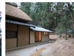
保存管理施設の設置
