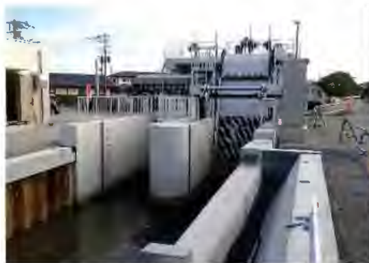
雨水ポンプ場の整備
