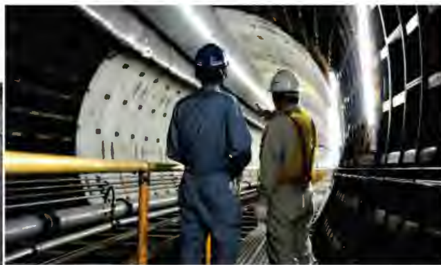
雨水貯留管の整備
