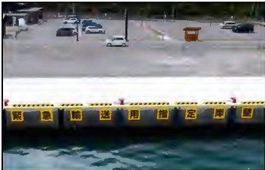
くれ 久礼港 (岸壁の改良)
