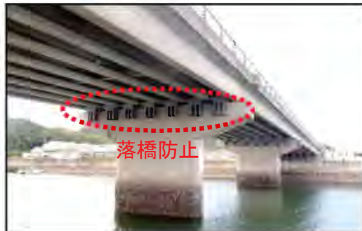
新居浜港 (橋梁の改良)
