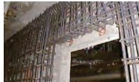
RC断面増厚工法による躯体の補強
