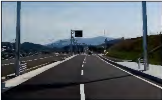
徳島小松島港 (臨港道路の整備)
