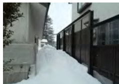
安全対策事例 (飛散防止フェンス)
