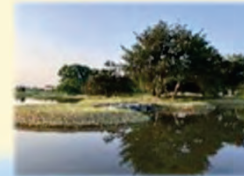
特別史跡無量光院跡での修景整備（岩手県平泉町）
