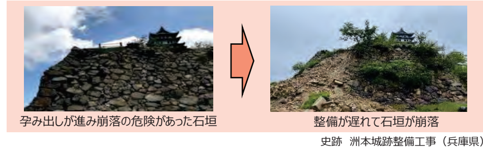
史跡 洲本城跡整備工事（兵庫県）
