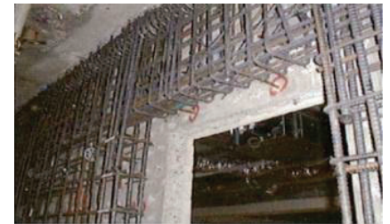
RC断面増厚工法による躯体の補強
