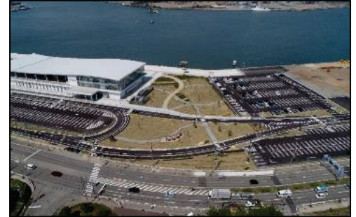
金沢港 (緑地・臨港道路の整備)
