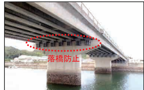
新居浜港 (橋梁の改良)
