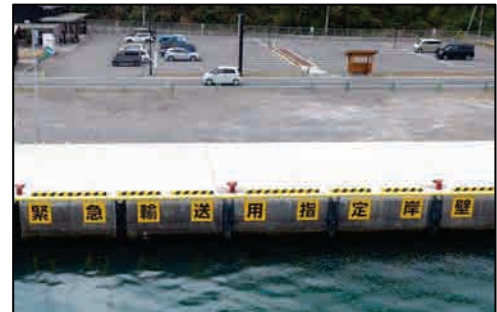
くれ 久礼港 (岸壁の改良)
