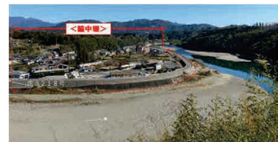
輪中堤整備事例 宮崎県延岡市
