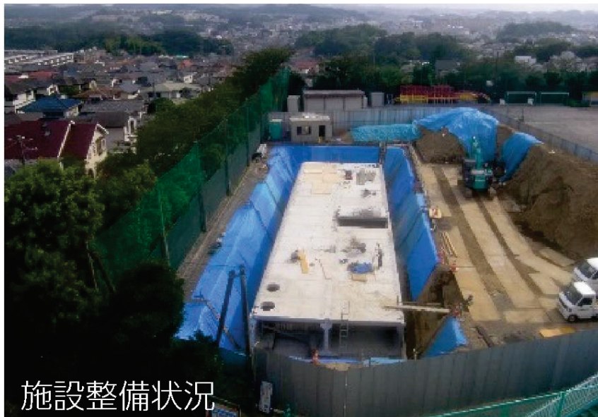
学校の校庭を利用した流域貯留施設 (神奈川県横浜市)
