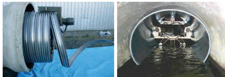
計画的な改築・更新(管路の更生工法)
