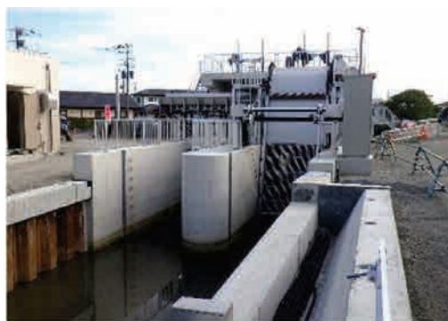
雨水ポンプ場の整備
