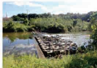
切り欠き部を有する 落差工 (矢田川 (愛知県))
