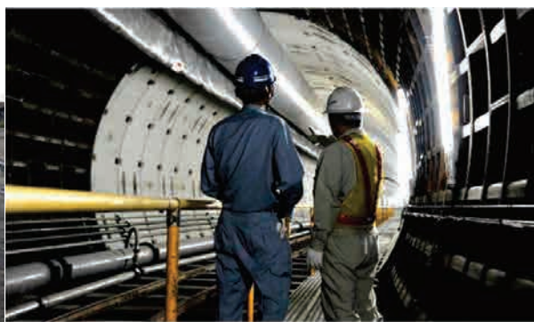
雨水貯留管の整備
