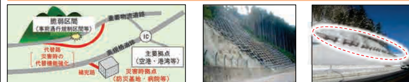
重要物流道路の代替路や補完路の整備
