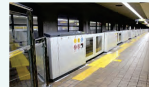
可動式ホーム柵の設置
