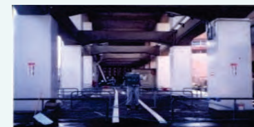
高架橋の耐震対策
