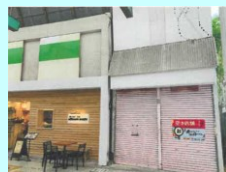
＜空き店舗リノベーション＞ （山口市）
