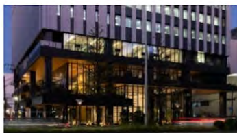
北西側低層部外観
