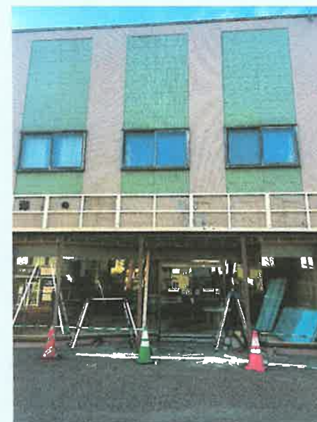
改装工事の様子
