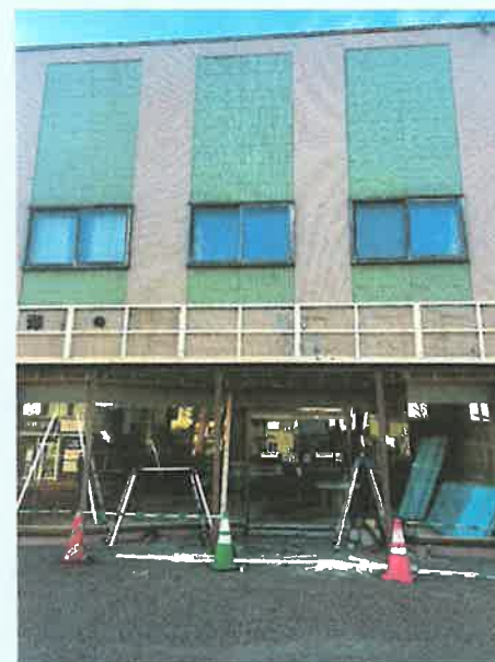
改装工事の様子
