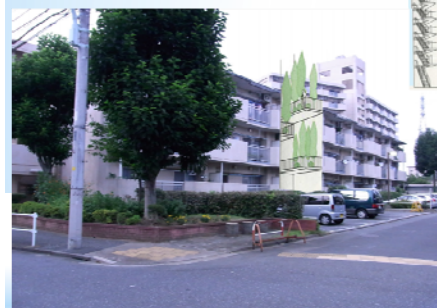
階段室やエレベータシャフトの緑化
