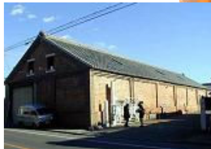
伝統的建築物
