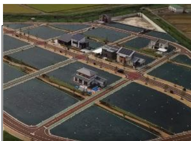
上空からのドローン写真
