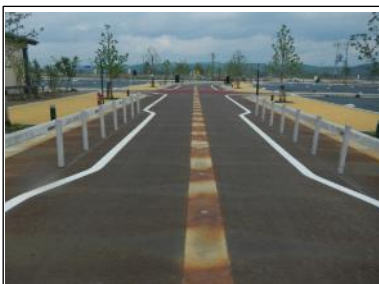
道路（狭さく部分）
