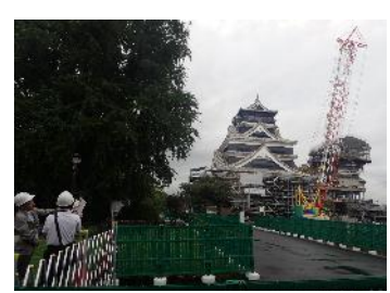
復旧中の天守閣
