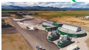
町内のバイオガスプラント
