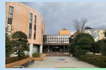
(仮称)ひと・夢・未来創造拠点複合施設を整備中
