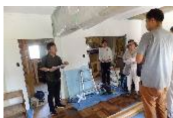
こどもの居場所や活動の場 (内装工事中)
