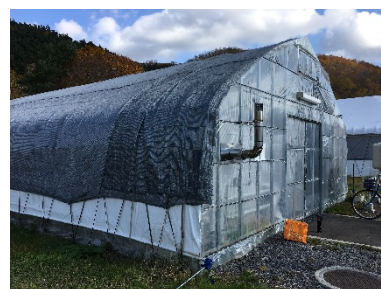
熱エネルギーを利用した 椎茸栽培施設
