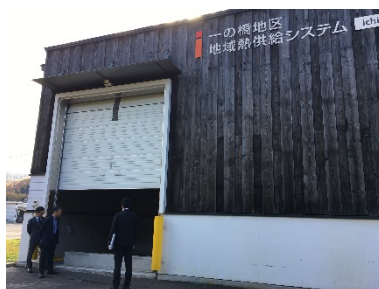
地域熱供給システム (外観)
