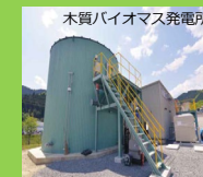
木質バイオマス発電所
