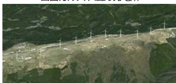
四国カルスト風力発電所
