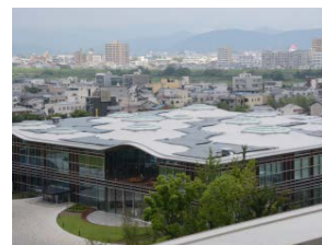
地中熱や太陽光などを積極的に活用したぎふメディアコスモス
