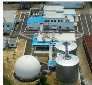
生ごみバイオガス発電センター
