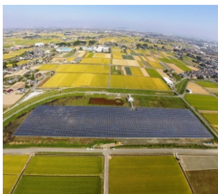
市有地へのメガソーラ設置
