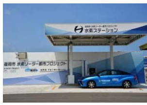
下水バイオガス水素ステーション
