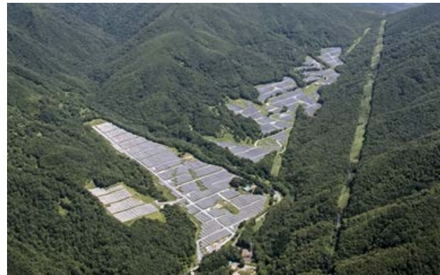
五葉山太陽光発電所（発電能力：18MW）
