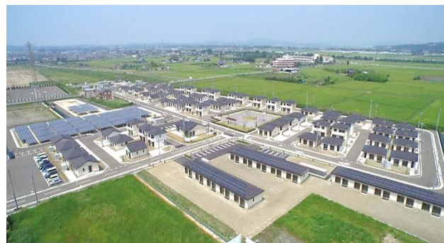
「東松島市スマート防災エコタウン」
