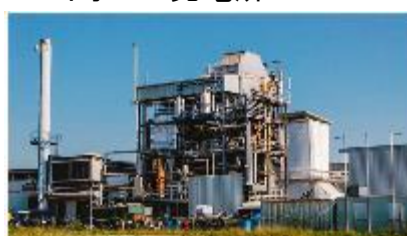
バイオマス発電所
