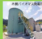
木質バイオマス発電所
