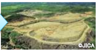
◎JICA 覆土によるごみの飛散・流出を防止
