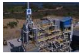
◎JICA 廃棄物発電施設
