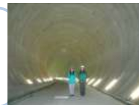
(洪水地下放水路の整備)
