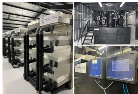
閉鎖循環式畜養システム
