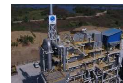
廃棄物発電施設
