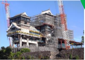
復旧中の熊本城
