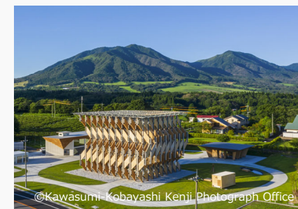
CLTとは、Cross Laminated Timberの略称。欧州で発達し、中層住宅の材料として使用されている
