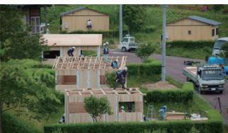
住田町仮設住宅
