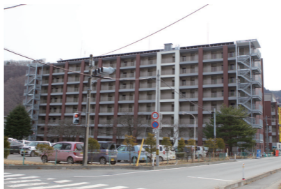
エネルギー自立性を高めるとともに省エネとCO2削減に貢献するスマート復興公営住宅
