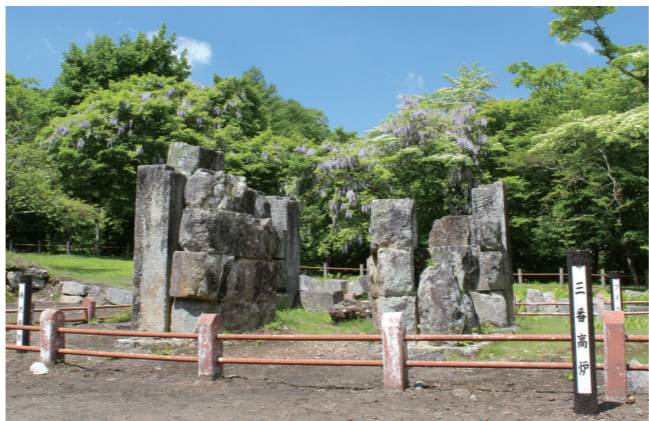
橋野高炉跡の三番高炉。花こう岩の基壇2段の上に約5.4メートル四方、高さ2.8メートルの石組み（5段）が積み、四隅に縦長の花こう岩が配置されている
