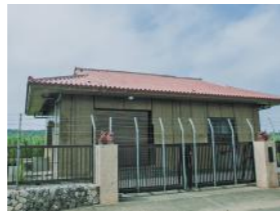
地下ダムから水を汲み上げるポンプ小屋が島内のあちこちに設置されている。ここからファームpondと呼ばれるタンクに水を汲み上げ、畑にスプリンクラー施設などを通して散水している。
