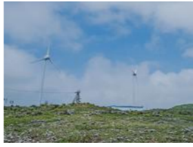
宮古島の風力発電の歴史は古く、1992年に1号基が稼働。現在は2003年の台風での倒壊事故の教訓を生かしブレードに改良を加えた風力発電施設が5基建っている。
