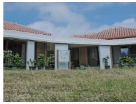
宮古島のエコハウスは、母屋と離れという伝統的な様式をもとに、花ブロックによる日影や季節の風を上手に取り入れる植栽でエアコンを必要としない住まいを実現している。台風対策に屋根材を活用していることも特長のひとつだ。
