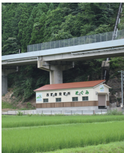
290kWの小水力発電所「めぐみ」
