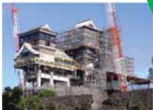
復旧中の熊本城
